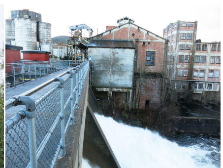
04. Gangstien over fossen gir en unik utsikt over fabrikkens.
